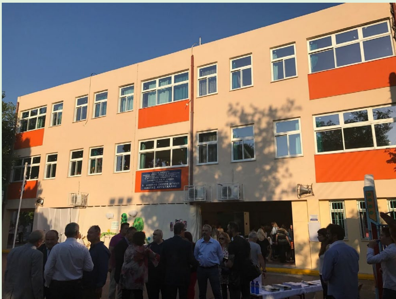
Εικόνα 1 8 ο Δημοτικό Σχολείο Αιγάλεω μετά την αντικατάσταση των υαλοπινάκων
